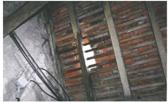
Photographie du rampant Est de la toiture
