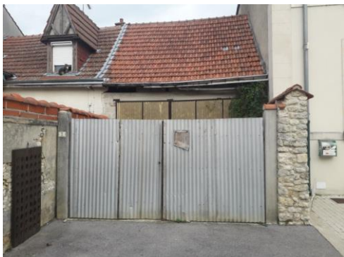
Bâtiment à démolir
